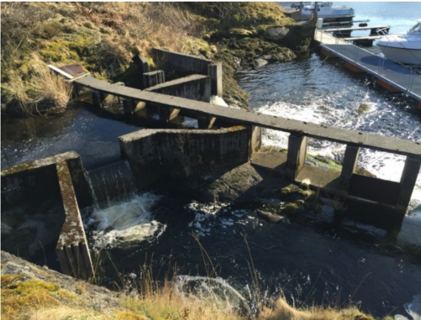
Ålørret felle på Manger (Radøy kommune). Blankål blir fanget når de vandrer ut av Nesvatnet fra august til november.
