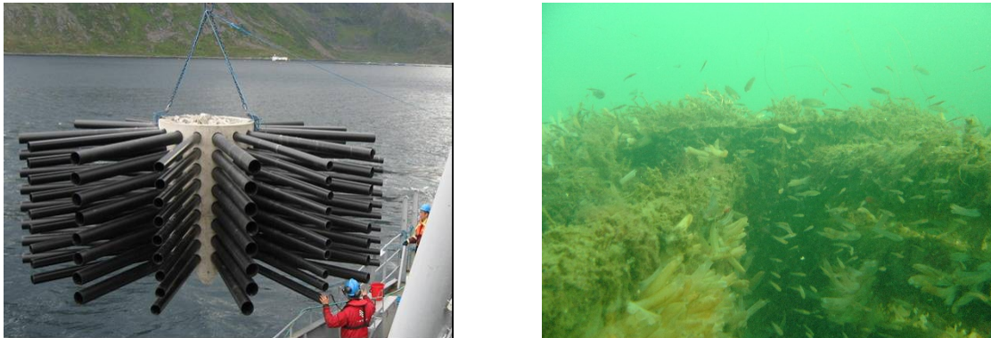
Figur 33. Utsetting av Runde rev (venstre) og tidlig fase med begroing med alger og ansamling av små fisk på et av revene ved Risør (høyre). Foto: Hartvig Christie (NIVA).
