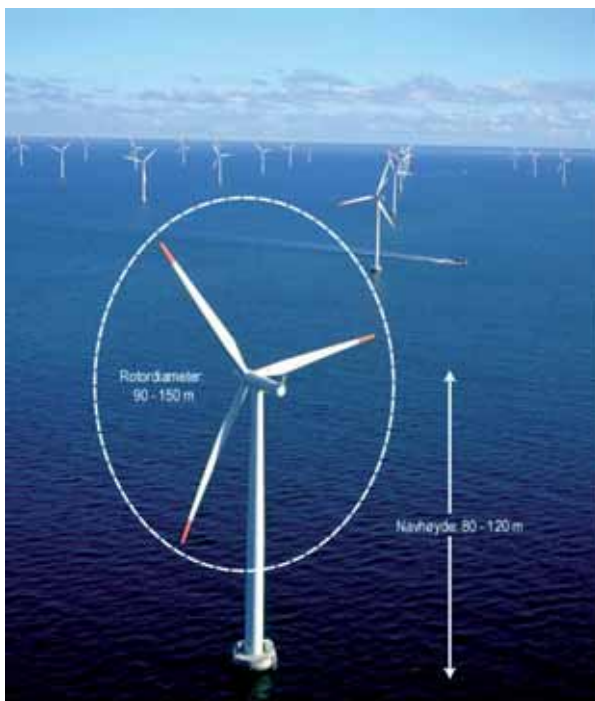
Figur 5. Eksempler på rotordiameter og navhøyde for vindturbiner til havs. Examples of the rotor diameters and hub heights of offshore wind turbines. Kilde/source: www.nystedhavmoellepark.dk . Foto: Jan K. Winther.
